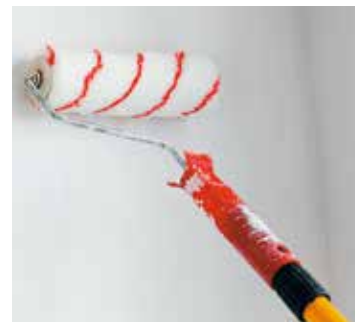
3 Нанесите клей валиком на стену. Не наносите слишком много клея.
