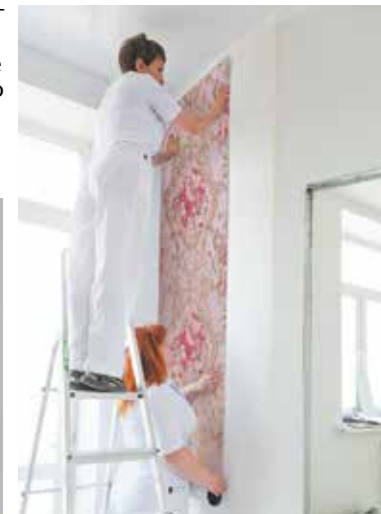
4 Наклейте полотно согласно отмеченной линии на стене.
