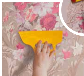
5 Совместите рисунок и разгладьте обои резиновым валиком или мягким шпателем.
