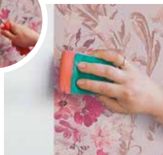
6 При попадании клея на поверхность панно для его устранения используйте только СУХУЮ губку.
