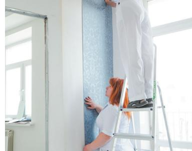
4 Наклейте полотно согласно отмеченной линии на стене.
