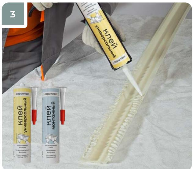
Равномерно нанести на монтажную поверхность (только на места примыкания к стене) клей «Европласт Монтажный» или «Европласт Универсальный» по всей длине изделия. Толщина наносимого слоя клея должна составлять 3–5 мм.
