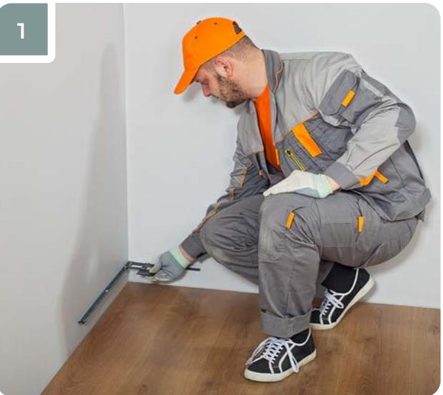
С помощью угломера произвести замер угла помещения.
