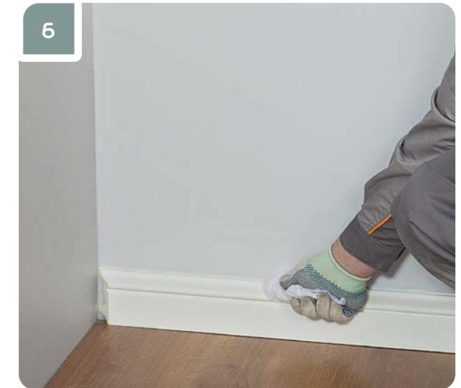
При необходимости места примыкания изделия к стене протереть ветошью, смоченной водой — при использовании клея «Европласт Монтажный», ацетоном — при использовании клея «Европласт Универсальный».
