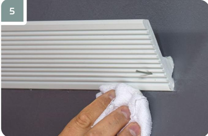
Удалить излишки клея ветошью, смоченной водой — при использовании клея «Европласт Монтажный», ацетоном — при использовании клея «Европласт Универсальный».
