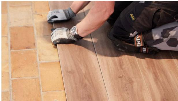
Для укладки последнего ряда панели приходится сужать. Это делается следующим образом: положите панель поверх предыдущего ряда пазом к стене, положите еще одну панель лицевой стороной вниз, прислонив ее к стене, и сделайте пометки на нижней панели. Разрежьте панели, сузив их до нужного размера, и уложите таким образом последний ряд.
